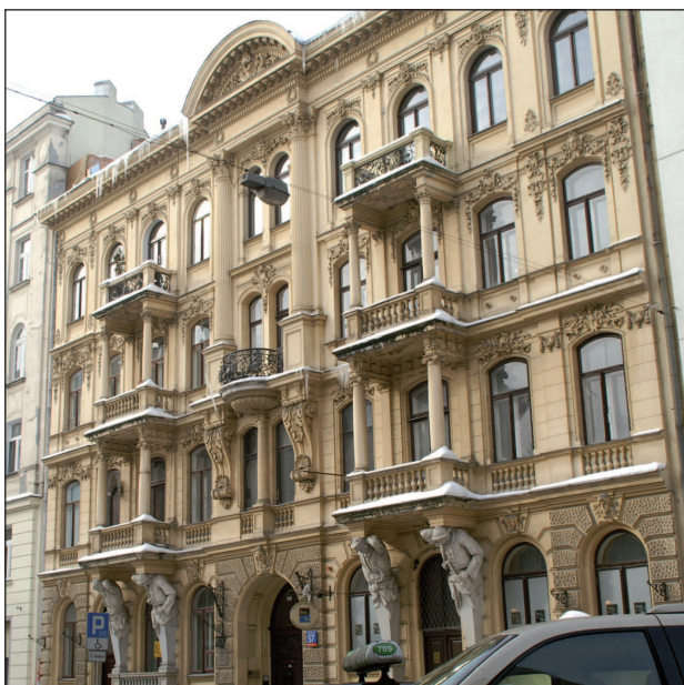
40. Fasada kamienicy przy ul. Mokotowskiej 57. Fot. J. Roguska, 2002
