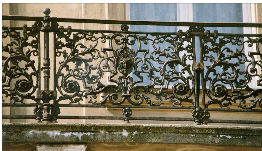
26. Balustrada balkonu w pałacowej kamienicy przy ul. Zielnej 49. Fot. J. Roguska, 2002 26. Balustrade of the balcony in the palace tenement house at 49 Zielna St. Photo: J. Roguska, 2002
