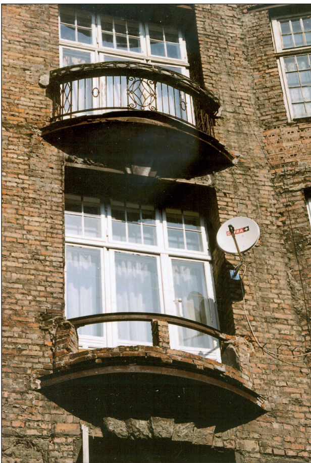
33. Balkony kamienicy przy ul. Próżnej 14. Fot. J. Roguska, 2002 33. Balconies in the tenement house at 14 Próżna St. Photo: J. Roguska, 2002
