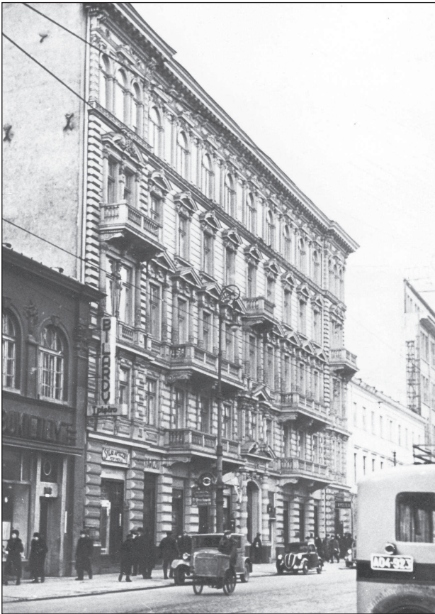
44. Kamienica przy ul. Nowy Świat 7, czteropiętrowa. Stan w 1938 r. APW. Referat Gabarytów 44. Tenement house at 7 Nowy Świat, four floors. State of 1938 APW. Referat Gabarytów
