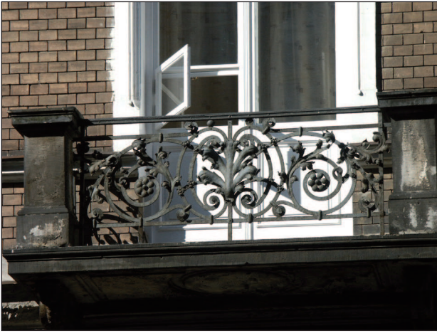
29. Balkon w kamienicy przy ul. Nowogrodzkiej 48. Fot. J. Roguska, 2005 29. Balcony in the tenement house at 48 Nowogrodzka St. Photo: J. Roguska, 2005
