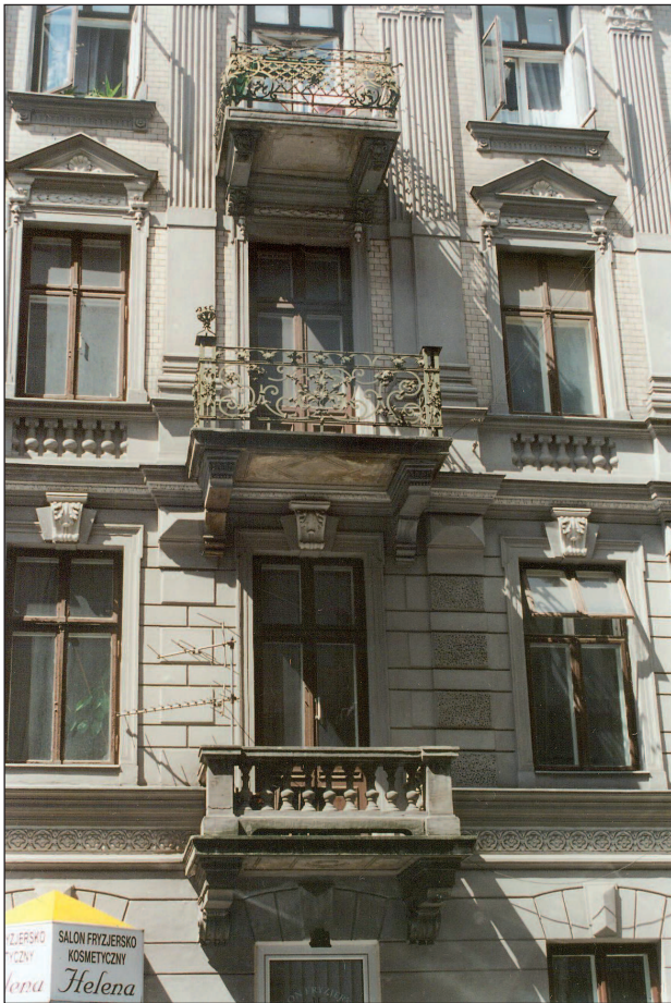
35. Balkony kamienicy przy ul. Wilczej 32. Fot. J. Roguska, 2002
