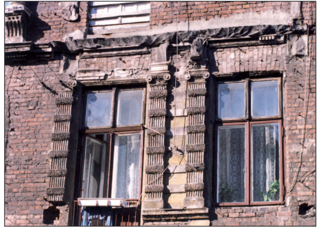
8. Relikty płyty i wsporników balkonu w kamienicy przy ul. Mokotowskiej 73. Fot. J. Roguska, 2004 8. Relicts of the slab and truss of the balcony in the tenement house at 73 Mokotowska St. Photo: J. Roguska, 2004
