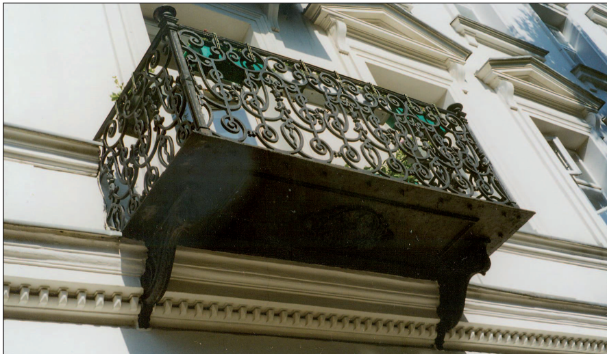
13. Balkon w kamienicy przy ul. Hożej 61. Fot. J. Roguska, 2004 13. Balcony in the tenement house at 61 Hoża. Photo: J. Roguska, 2004
