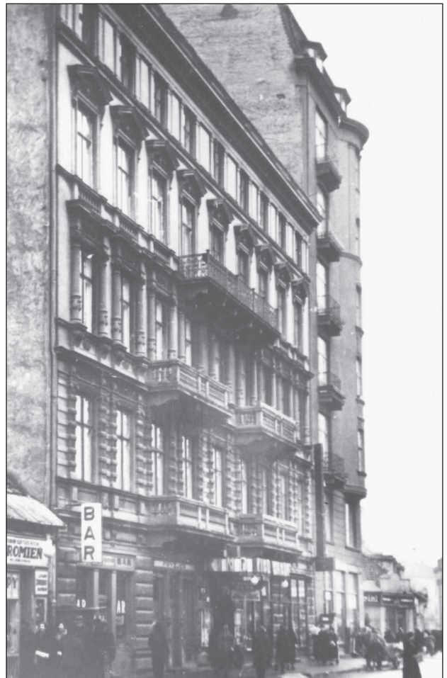
8a. Widok kamienicy przy ul. Mokotowskiej 73. Archiwum m. st. Warszawy (dalej APW). Zbiór fotografii Referatu Gabarytów, 1938 8a. View of the tenement house at 73 Mokotowska St. Archive of the capital city of Warsaw (hereinafter referred to as the APW). Photo collection of Referatu Gabarytów, 1938
