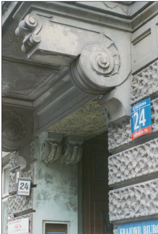
22. Wspornik balkonu nad wjazdem kamienicy przy ul. Koszykowej 24. Fot. J. Roguska, 2002 22. Balcony's truss over the entrance to the tenement house at 24 Koszykowa St. Photo: J. Roguska, 2002
