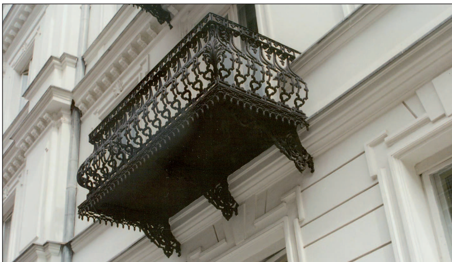
14. Balkon w domu przy ul. Śniadeckich 19. Fot. J. Roguska, 2004 14. Balcony in the house at 19 Śniadeckich. Photo: J. Roguska, 2004
