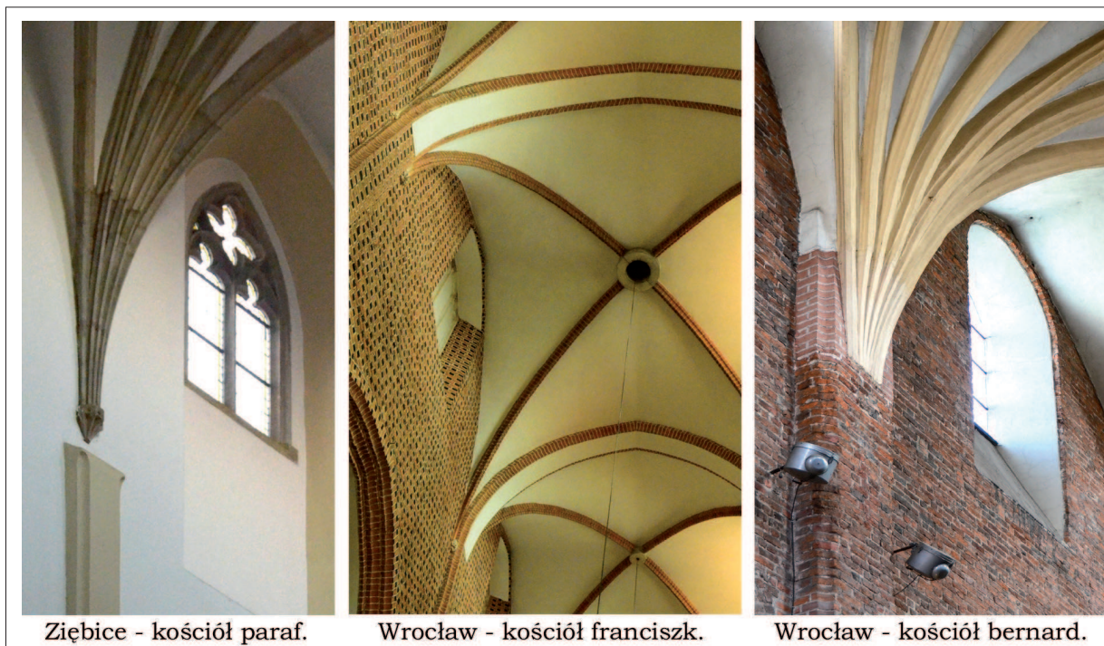
34. Osadzenie żeber w kościołach bazylikowych 34. Rib mounting in basilica churches
