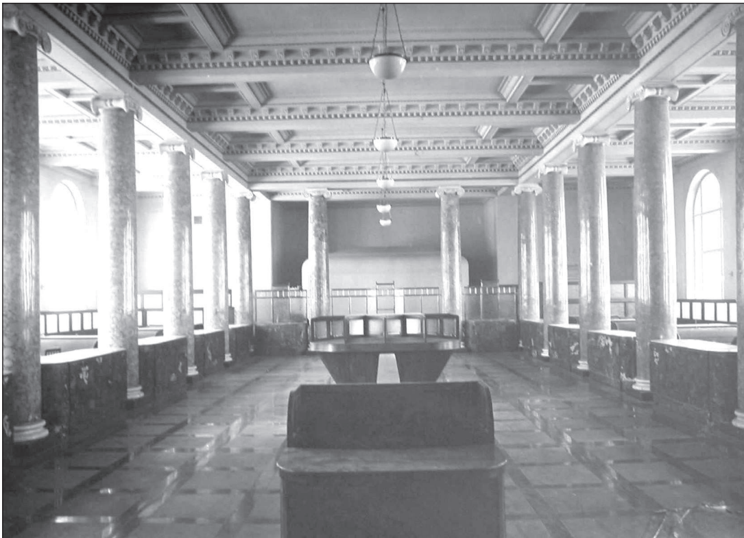
17. Warszawa, gmach Centrali Pocztovej Kasy Oszczędnosci przy ul. Świętokrzyskiej 31/33 (1921-1923) – wnętrze głównej sali operacyjnej (stan ok. 1923). Proj. J. Handzelewicz (1921). Zb. R.
