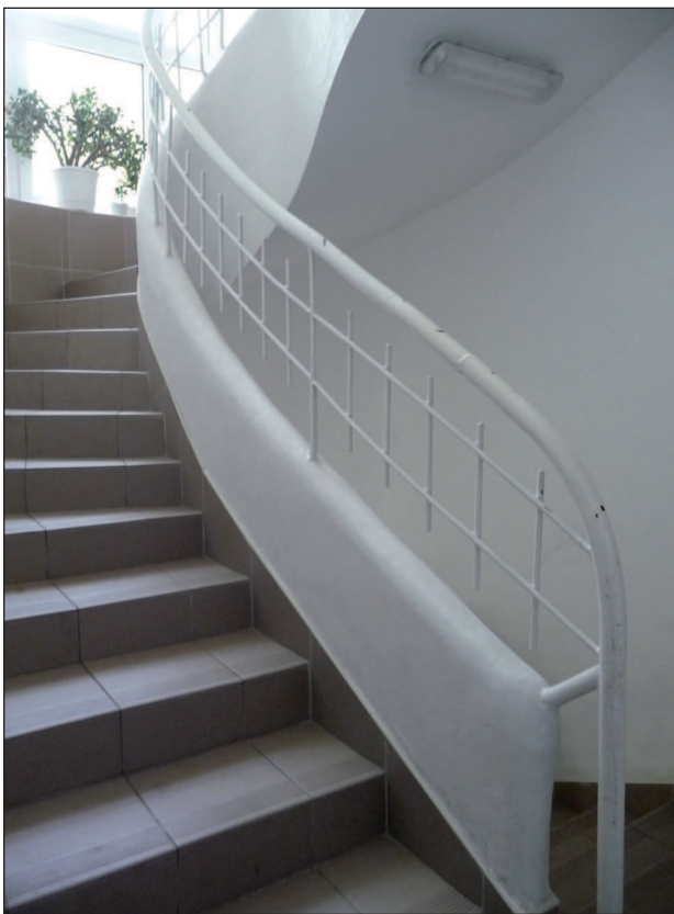
15. Klatka schodowa w budynku przy ul. Cieszyńskiej 8. Fot. E. Popławska-Bukała, 2010 15. Staircase in the villa, 8 Cieszyńska Street. Photo: E. Popławska-Bukała, 2010
