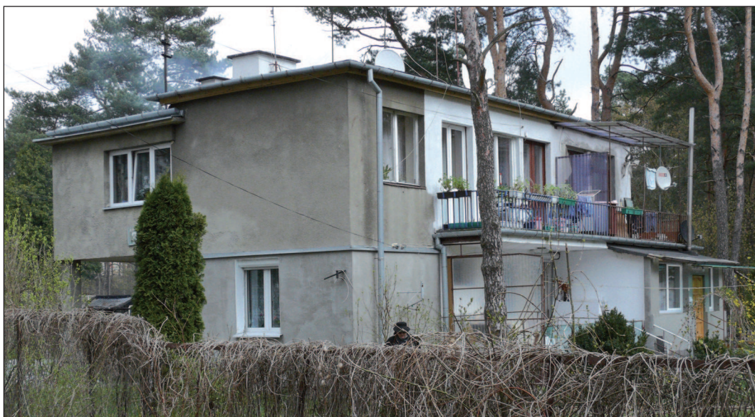
4. Budynek przy ul. Krasieńskiego 30 – widok od strony pd.-zach. Fot. B. Chmielarska-Łoś, 2009 4. Residential house, 30 Krasieńskiego Street, view from the South-West. Photo: B. Chmielarska-Łoś, 2001
