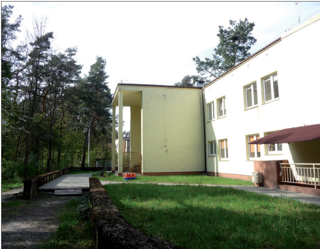
9. Widok willi przy ul. Cieszyńskiej 5 od strony wsch. Fot. E. Popławska-Bukało, 2010 9. View of the villa, 5 Cieszyńska Street from the East. Photo: E. Popławska-Bukało, 2010
