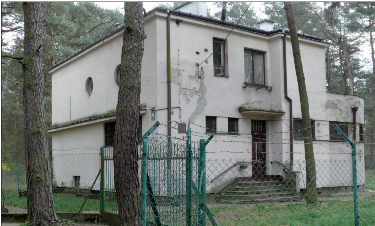
26. Widok elewacji budynku przy ul. Syrkomli 4 – od strony zachodniej. Fot. B. Chmielarska-Łoś, 2009 26. View of the building elevation from the West, 4 Syrokomli Street. Photo: B. Chmielarska-Łoś, 2009
