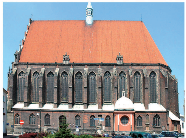
Nysa - kościół parafialny św. Jakuba, elewacja pd
