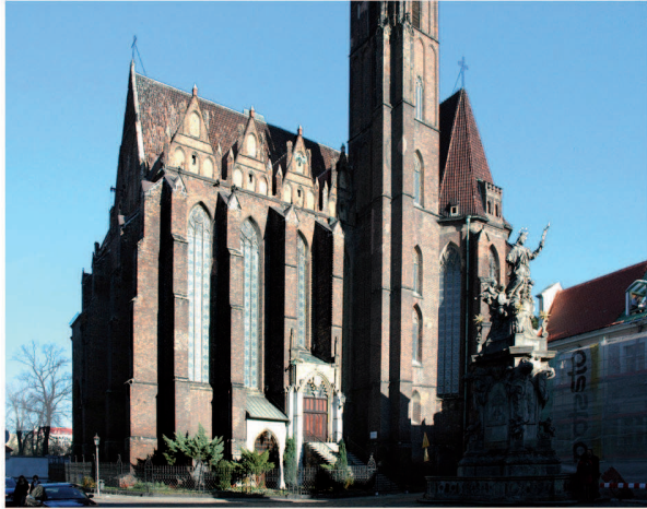
Wrocław - kolegiata św. Krzyża, elewacja pd
