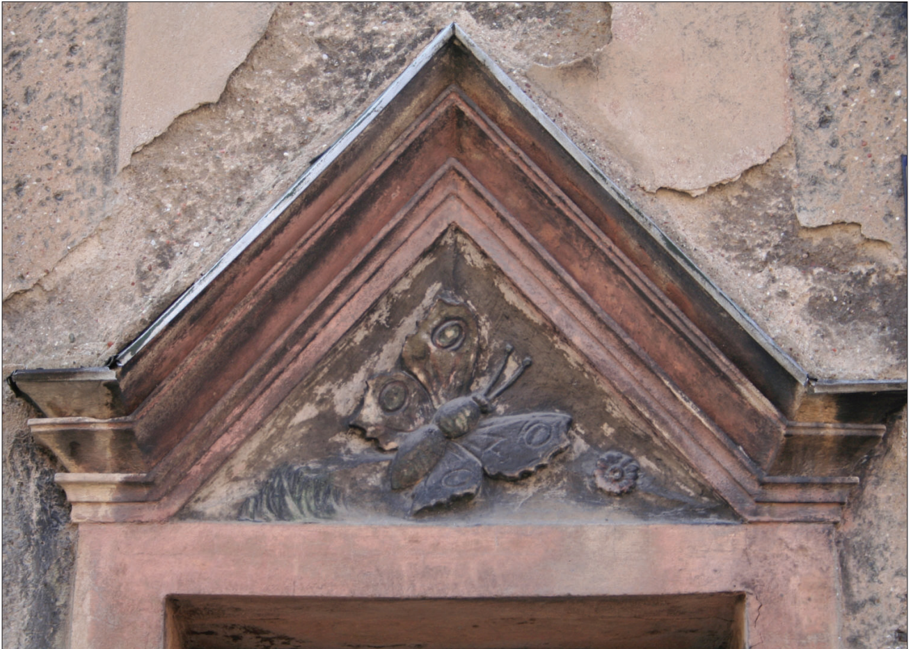
1. Tympanon portalu o gzymsach zgeometryzowanych nawiązujących do klasycznych wzorów w budynku modernistycznym na Nowym Mieście przy ul. A. Fredry w Wałbrzychu, 1925 r. Fot. autor, 2008 r.
